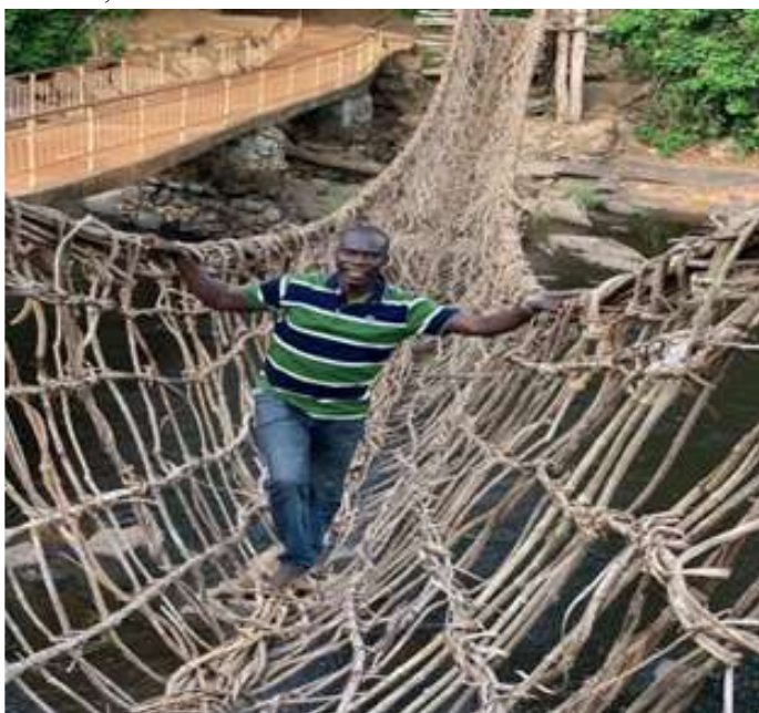
Photo 3 : Le pont de lianes de Lieupleu : Cliché de l'auteur, août 2022.
